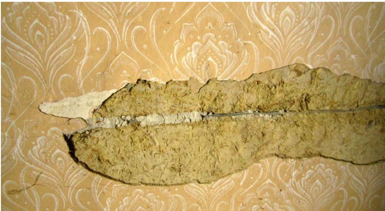
električne instalacije u zidovima od zemlje
