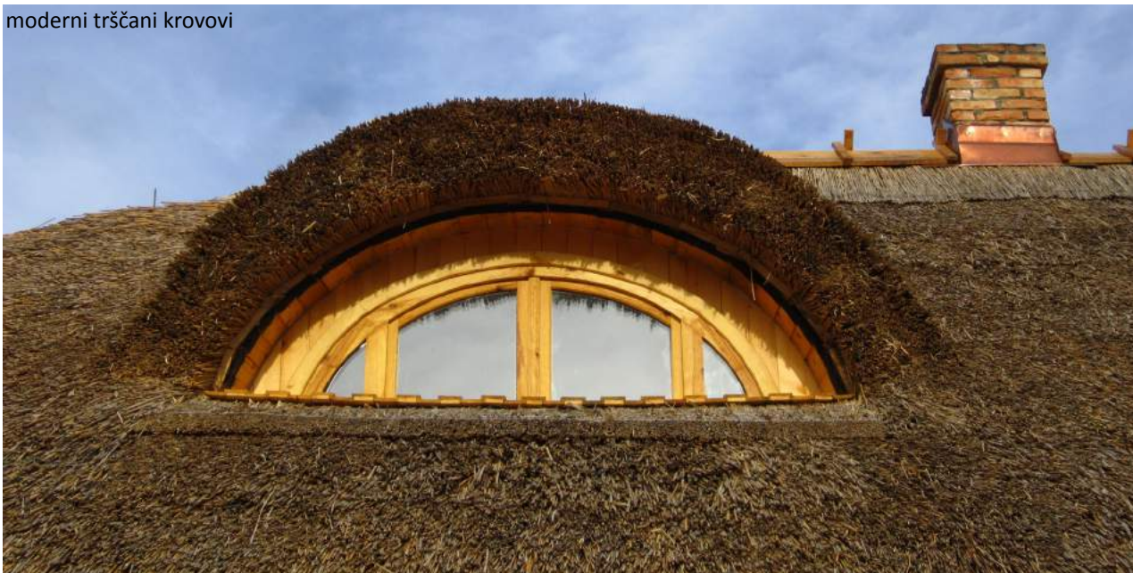
moderni trščani krovovi
