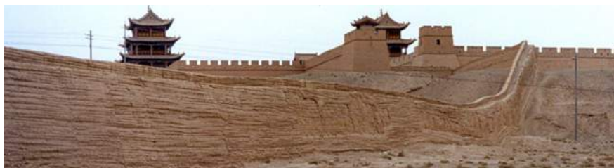
deo Kineskog zida građen zemljom
