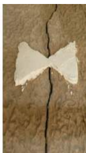
priprema zidova, testiranje pukotina i način ispune pukotina u zavisnosti od veličine
