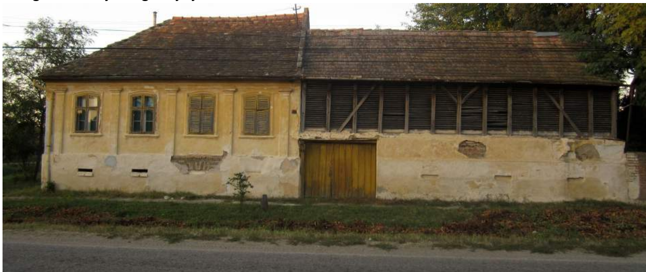
objekat u Gudurici
